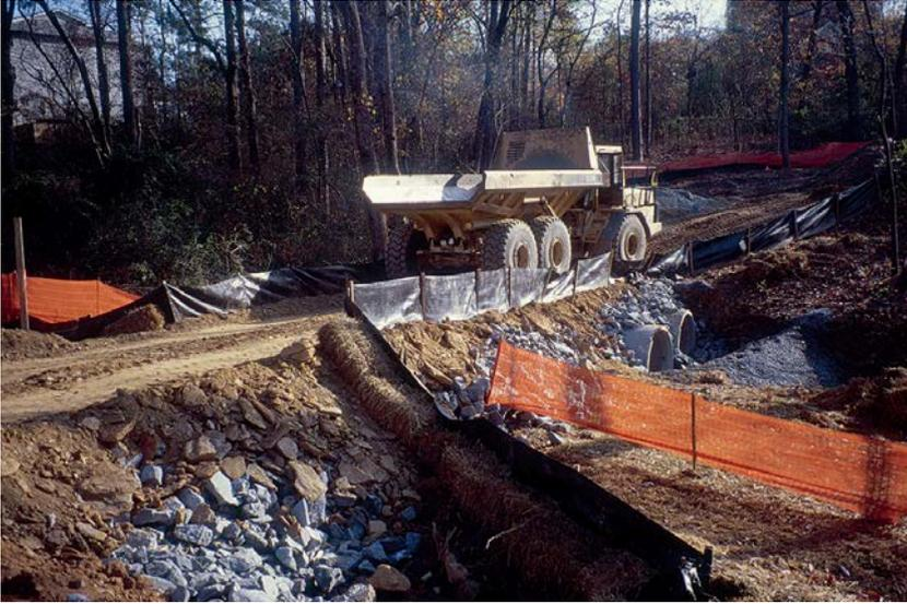
Buen uso de barreras de sedimento, paja, piedras y otras prácticas para el cruce temporal de arroyos. Cualquier trabajo en canales de arroyos, como la instalación de alcantarillas, requiere un permiso de la Sección 404 del Cuerpo de Ingenieros del Ejército de EE. UU. y una Certificación de Calidad del Agua de la Sección 401 de la División de Agua de KY.
