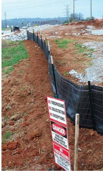
Muy buen uso de una cerca de sedimento “súper” (reforzada) continua y una barrera de sedimentos de roca proyectada (lado opuesto) para filtrar la escorrentía fangosa del sitio de desarrollo comercial. Tenga en cuenta que se instala una cerca de alambre entre la tela filtrante y los postes.
