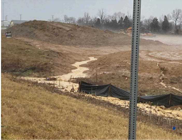
La ubicación de la barrera contra sedimentos es incorrecta y no está excavada. La mala instalación ha provocado que el agua fluya alrededor del borde y debajo de la barrera contra sedimentos.
