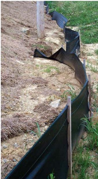
Buen uso del gancho en forma de J en la cerca para atrapar sedimentos en el agua que corre a lo largo de la cerca. El sedimento debe eliminarse cuando alcance un tercio de la altura de la barrera contra sedimentos.
