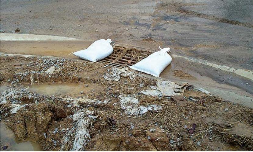
Mal trabajo de siembra y protección de la entrada de la acera con bolsas de piedras. El proyecto no debe cerrarse hasta que todas las áreas de suelo desnudo tengan vegetación y se hayan eliminado todos los controles temporales (presas de entrada, controles de sedimento, cercas de sedimento). Presente un “Aviso de terminación” ante la División de Agua de KY cuando se complete el proyecto.
