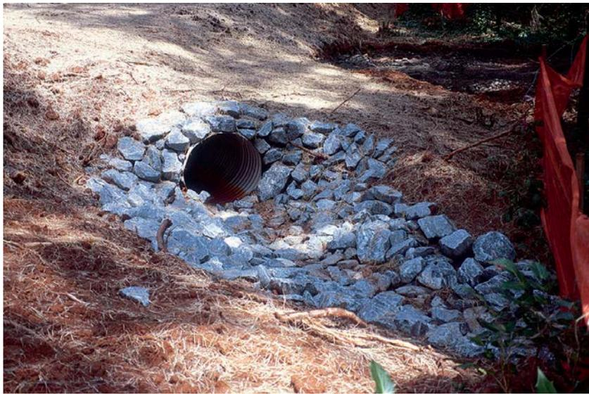
Excelente instalación de disipador de flujo de roca en la salida de la alcantarilla. Asegúrese de que las entradas, salidas y pendientes estén bien estabilizadas antes de abandonar el sitio y presentar su “Aviso de terminación” para finalizar la cobertura del permiso.
