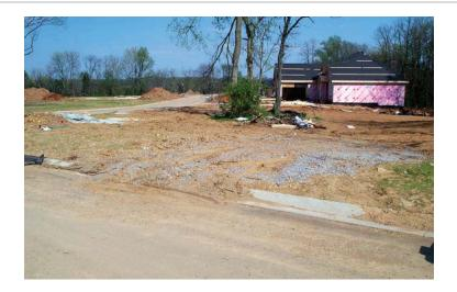
La plataforma de roca está mal construida; La roca es demasiado pequeña. Utilice tela filtrante debajo de rocas y rocas de mayor tamaño, como la n.º 2. No se debe dejar rastro de barro en las carreteras pavimentadas y abiertas al tráfico.
