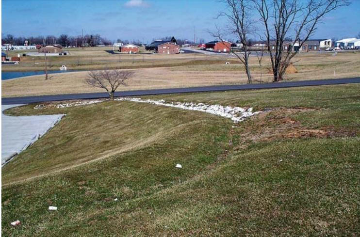
Buena construcción, siembra y estabilización de la berme de desvío. Tenga en cuenta que la fosa de desvío está revestida de hierba en la parte más plana de la pendiente, y con roca en una parte más empinada.
