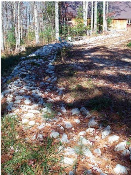
Buena instalación de bermela rocosa para desviar la lluvia en torno a un lugar de construcción residencial en una pendiente abrupta cerca de un río. Los pozos de desvío pueden estar revestidos con hierba si las pendientes de los canales son 20:1 o menos, y con tapices o tapices de césped si son más abruptos.
