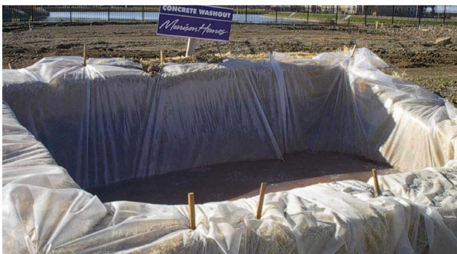
Estructura de contención aceptable para residuos de hormigón y agua de lavado de camiones. Asegúrese de que las estructuras adicionales estén disponibles a medida que las existentes se llenan.
