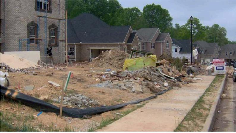
Desechos sólidos deficientes, cercas contra sedimentos y otros controles. La falta de control de desechos y sedimentos constituye una violación del permiso de aguas pluviales de KPDES.
