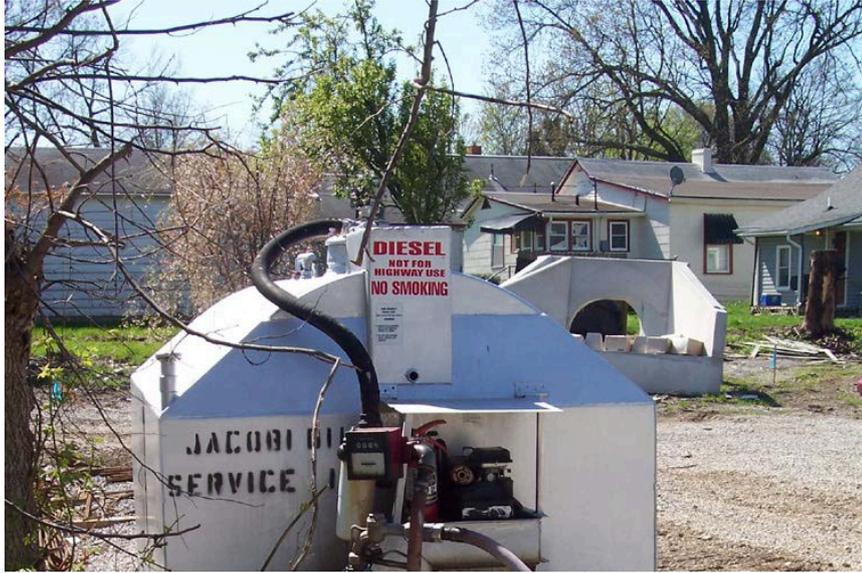
Deben utilizarse tanques de combustible de pared doble. Localizarlos lejos de los agujeros, los desagües de la tormenta y las vías fluviales.
