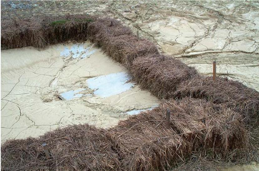
Los fardos de paja se han podrido y han fallado, y el escurrimiento fangoso socava los fardos. La plataforma de concreto y la rejilla de entrada están casi cubiertas de sedimento. Utilice paja únicamente como mantillo.
