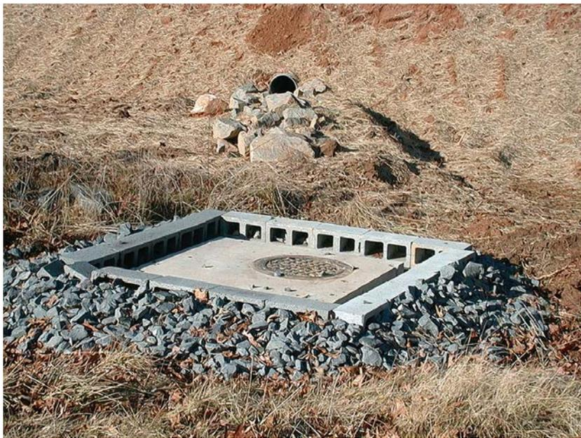
Muy buen diseño e instalación de presa de protección de entrada mediante bloques de hormigón y roca. La tubería de salida al fondo tiene una plataforma de roca para disipar los flujos.
