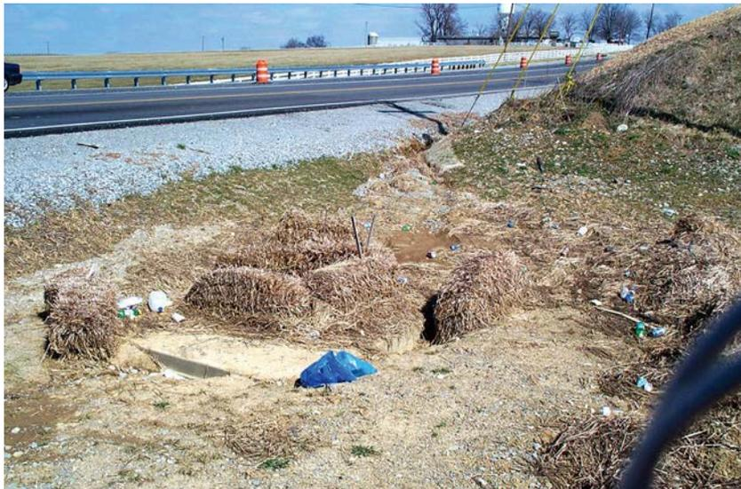
Mala protección para la entrada de agua en una plataforma de concreto. Los fardos de paja son un buen abono, pero no son adecuados para proteger las ensenadas ni para represas de retención de sedimentos.
