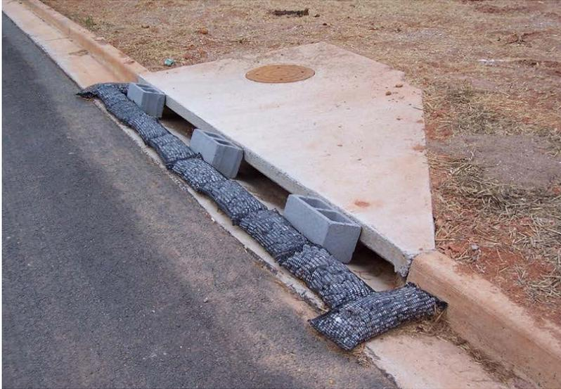
Excelente uso de tubos de malla rellenos de roca para controlar los sedimentos en la entrada de la acera. Los espaciadores de bloques de concreto evitan que los tubos se muevan hacia la entrada y la obstruyan durante flujos intensos.
