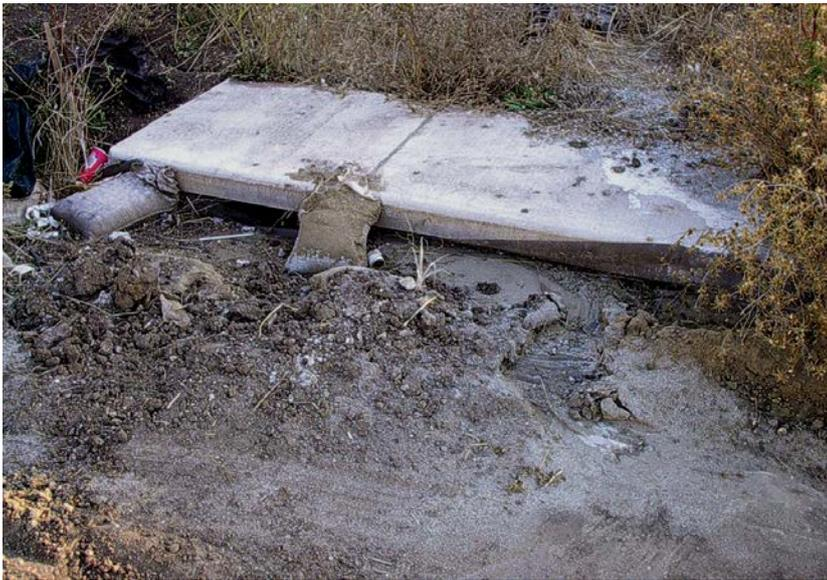
Mala colocación y mal mantenimiento de la presa de encharcamiento de entrada de bolsas de piedra. Se deben eliminar los sedimentos acumulados y reparar la presa después de cada media pulgada de lluvia.
