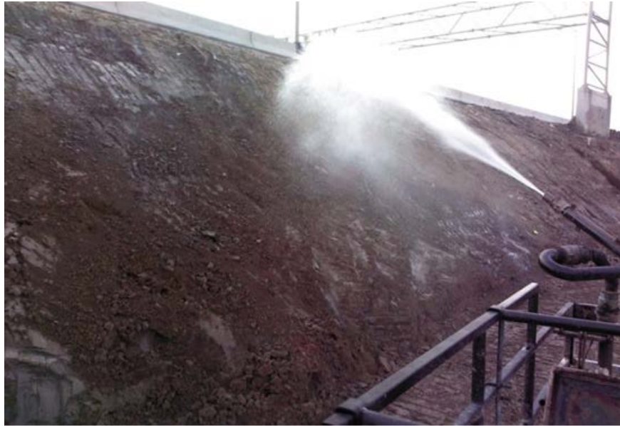
Tratamiento de una pendiente con spray de poliacrilamida
