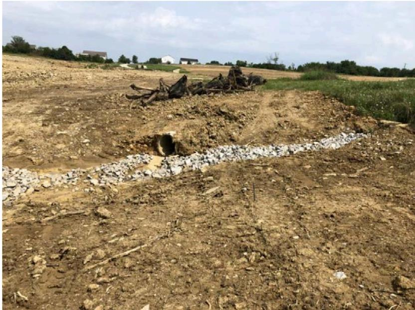
Salida de alcantarilla sin faldón de roca ni disipadores de flujo. No está claro si esta línea de roca estaba destinada a ser una presa de control o si se supone que dirige el flujo en otra dirección, pero no funciona en ninguno de los casos.
