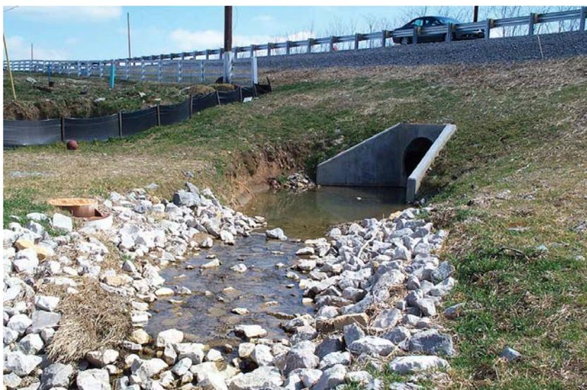
Buena instalación de cercas de sedimento, siembra justa y cobertura de mantillo en pendientes. Mala colocación y construcción de plataforma disipadora de flujo en la salida de la alcantarilla.
