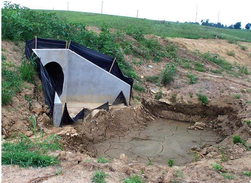
Mala protección de taludes, falta de plataforma de roca o disipador de flujo en la salida de la alcantarilla. No se debe utilizar barrera contra sedimentos a través de zanjas o canales; No coloque trampas de sedimentos en las salidas de las alcantarillas.
