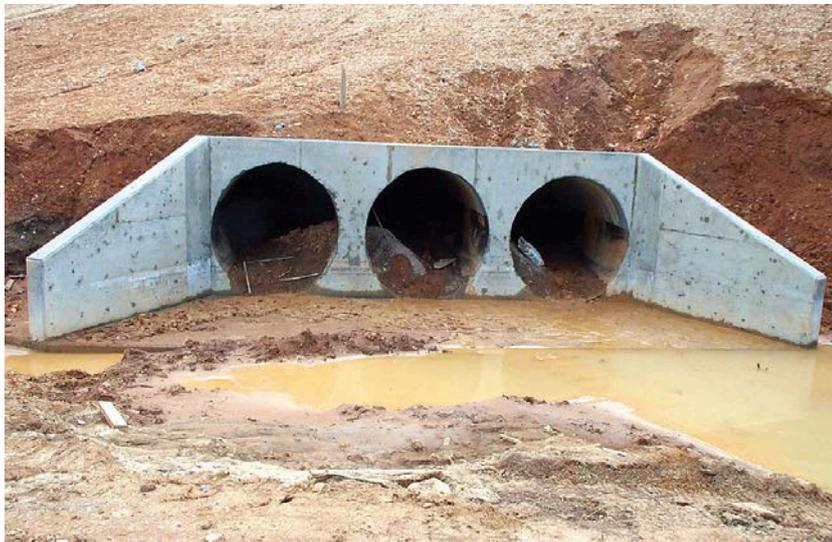
Mala aplicación de semillas y mantillo, pendientes muy erosionadas. No hay plataforma de roca ni disipador de flujo en la salida de la alcantarilla. Alcantarillas obstruidas con sedimentos y rocas.
