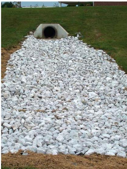
Buena ubicación y construcción de plataforma de roca en la salida de la alcantarilla de alto flujo. Si el flujo de la alcantarilla ingresa a un canal, asegúrese de que el canal esté revestido con pasto y mantas o esteras, si es necesario, para evitar la erosión.
