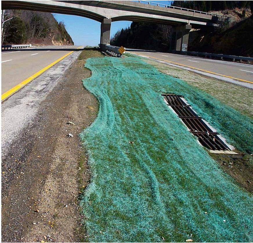
Buena aplicación de manta de control de erosión para estabilizar el arcén y proteger el drenaje pluvial, pero se utilizan muy pocas grapas a lo largo del borde superior. Zanja en el borde superior de la manta en pendientes pronunciadas.
