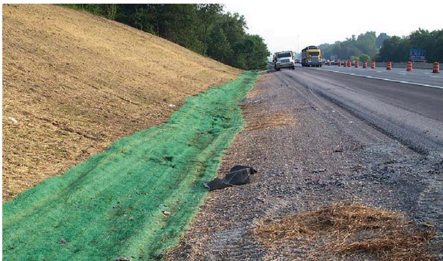
Muy buena instalación de una manta de control de erosión en una zanja sembrada debajo de una pendiente bien cubierta con mantillo en un proyecto de carretera.
