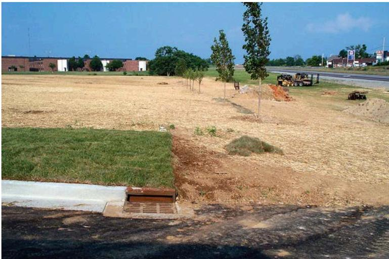
Buena mezcla de sod, semilla y mulch en el sitio del nuevo centro comunitario. Tenga en cuenta que la entrada debe ser protegida mediante la instalación de una roca o un saco de arena en el agua del estanque antes de que fluya a la entrada.
