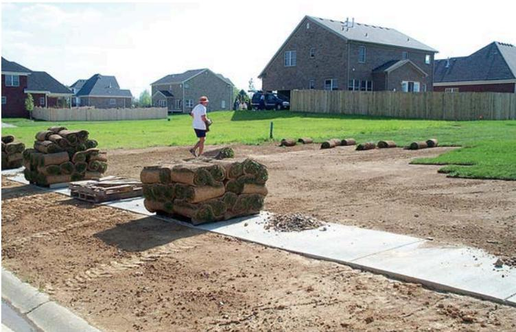
La instalación de sod inmediatamente después de que se haya completado el trabajo de clasificación puede reducir la erosión y la pérdida de sedimentos a casi cero.
