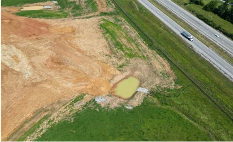
Buen estanque de sedimentos con desbordamiento. Tenga en cuenta las dos vallas de sedimento debajo del desbordamiento y encima de la zanja de drenaje estabilizada.
