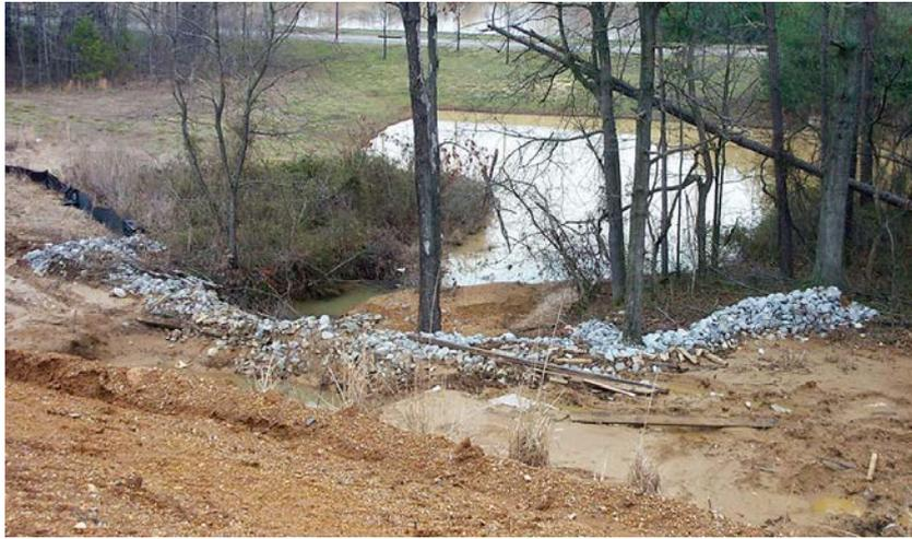
Mala construcción de trampas de sedimentos. El dique está mal construido, sin muesca de desbordamiento. La ubicación está demasiado cerca del estanque. No se observan semillas ni cobertura de mantillo en el área de drenaje.
