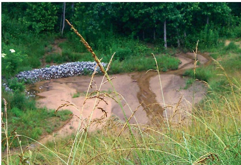
Buena instalación de trampa de sedimentos, pero el mantenimiento deficiente ha provocado que la trampa se llene y se produzca un desvío. Retire los sedimentos antes de que la trampa esté medio llena. Asegúrese de que el dique de contención tenga una muesca de desbordamiento para controlar la ubicación de la descarga.
