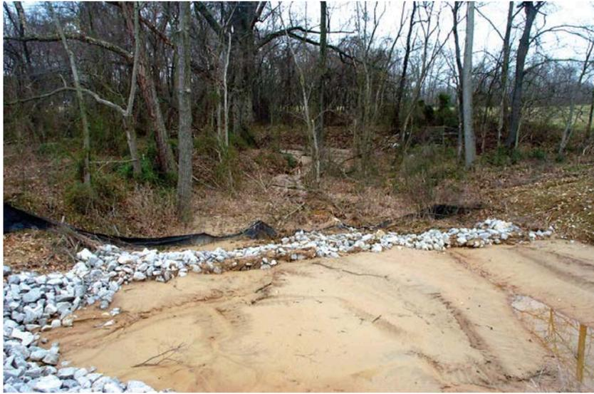
Construcción justa de trampa de sedimentos. El dique de roca tiene un tamaño insuficiente y carece de una muesca de desbordamiento definida. Mala atención de mantenimiento. No se necesita barrera contra sedimentos más allá del dique de roca; la barrera contra sedimentos no debe usarse a través de canales de flujo.
