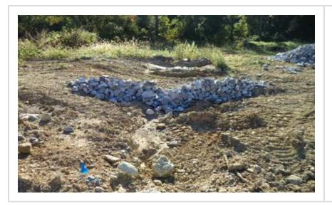
Agregado demasiado grande y de ancho no apropiado para el canal. Canal mal definido.
