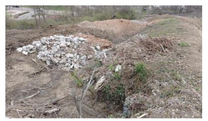
Presa de control de roca mal formada con mantillo apilado entre las presas.
