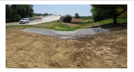
Buena conformación de la presa de retención de sedimentos. Tenga en cuenta el desbordamiento en la parte superior y el ancho suficiente para cubrir toda la zanja.
