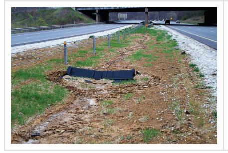
Mala aplicación del producto comercial de control de sedimentos. El control de sedimentos debe ser más largo (atado a los bancos). Se necesitan más, con el espaciado correcto para la pendiente del canal. Es necesario volver a sembrar el área; La zanja puede necesitar un revestimiento de manta.
