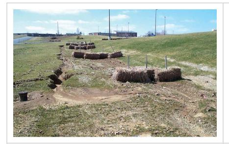
Mala instalación de presas de retención de sedimentos. Los fardos de paja no están aprobados como controles de sedimentos para aplicaciones en zanjas o canales debido a su pudrición, dificultades de instalación y alto potencial de fallas.
